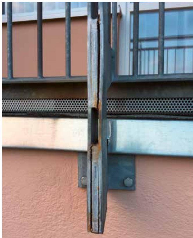
Dommages à un poteau de garde-corps galvanisé à chaud dont les chevauchements ne sont que partiellement soudés.
