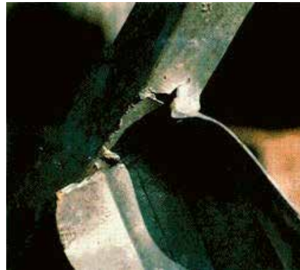
Ill. 10 : Construction de profilés creux rectangulaires qui ont été rompus dans le bain de zinc à cause de trous manquants.
